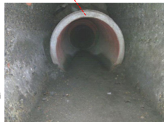
I vecchi cunicoli all'esterno dell'area interessata ai lavori in progetto sono stati sostituiti con tubazioni in calcestruzzo.
